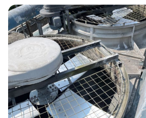
冷卻水塔更換節能葉片 能效提升作業
