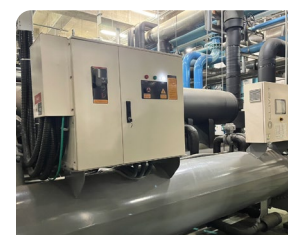
廠區 500RT 冰機汰換作業
